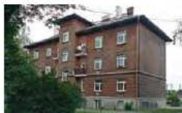
Bohumín, obytný dům č.p. 397, pohled od jihu, stav v roce 2012.
