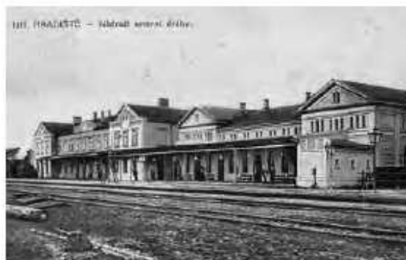
Staré Město u Uherského Hradiště, výhled původní výpravní budova rozšířená kolmými štíty s obloženými výhy, vpravo stavba připojená v roce 1902. Sběrka Mojžíš Leitínský, 1908 až 1914.
