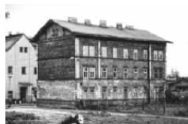
Ostrava-Svinov, služební obytný dům ustoupil koncepci otevřeného přednádraží s prosklenou přístavbou vjezdové budovy. Foto Mojmir Leitínský, 2003.
