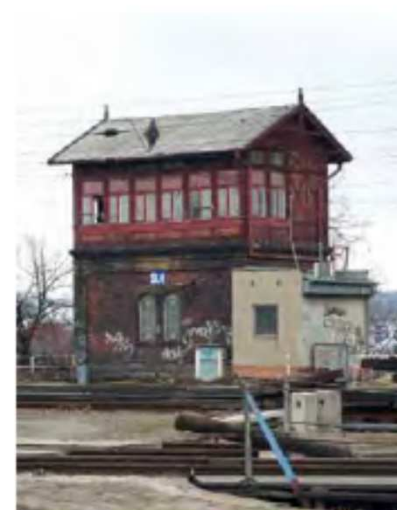
Brno, stávkově 5, stav v roce 2012.
