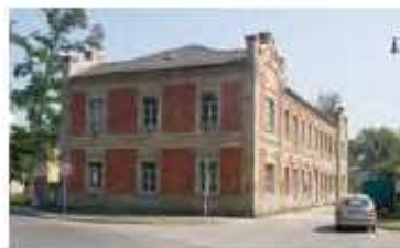
Bohumín, kancelářská budova, původní také kasárna, pohled od jihu, stav v roce 2012.
