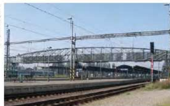
Bohumín, přechodová lávka nad kolejištěm zvaná celní, starší část, v pozadí vlnitostechy střešných nástupišť, pohled od severu, stav v roce 2010.
