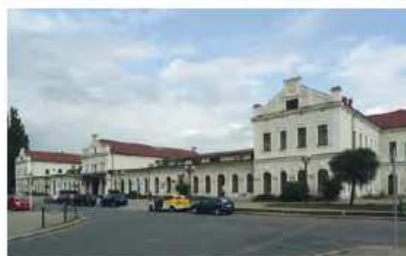
Bohumín, výpravní budova, pohled z ulice. Kolmá křídla se šitými výpravci a ve středu, spojená nižším traktem, určují polohu a již přestavěnou hmotou polohu původní výpravnice. Severní trakt, vlevo od středního kolmého křídla, rozšířily stavbu v letech 1901–1904. Stav v roce 2012.
