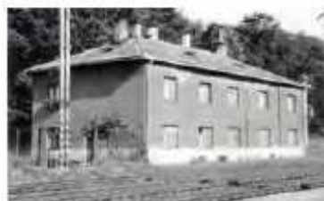
Napajedla, první výpravní budova, dnes obytný dům, stav v roce 1899.
