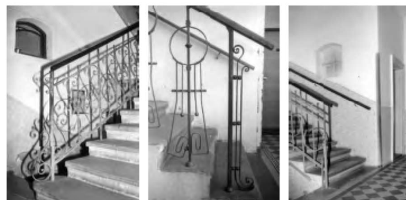
Přesto, že byly obytné domy (v tomto případě typ pro osm rodin Franze Bobrowského) realizovány podle stejného typového projektu, liší se použitými detaily, např. motivy kořového zábradlí. Zleva Brzenc-Prývoz, Drahotule, Hladě Živčice, Hučínovice a Nedačovice, stav v roce 1999.
