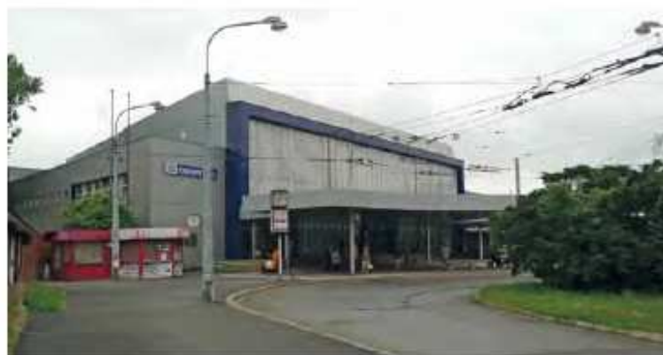
Ostrava hl. n., výpravní budova, pohled z přednádraží a vestibul, stav v roce 2012.
