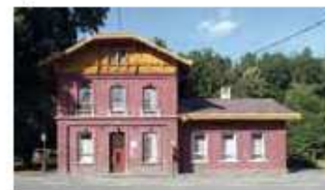
Mladáče, výpravní budova zastávky na trati Opava–Horní Benešov, uliční strana, 2012.
