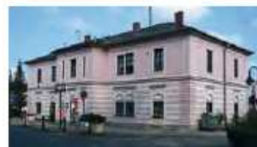
Rakousko, Deutsch Wagram, zádná výpravní budova roku 1851 nahradila provozní dřevěnou předchůdky. Stavba byla rozšířena symetrickou přístavbou, výpravo od středního rizalitu lze rozoznat tři osy původní ústřední fasády, pohled z přednádraží, stav v roce 2009.
