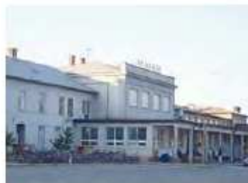
Břeclav, výpravní budova, pohled z přednádraží, stav v roce 2011.
