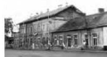
Otrokovice, výpravní budova byla postupně rozšířována, režné zdivo omítnuto. V rámci staršího tranzitního koridoru došlo k nástavbě přízemního křídla vpravo, stav v roce 1999.
