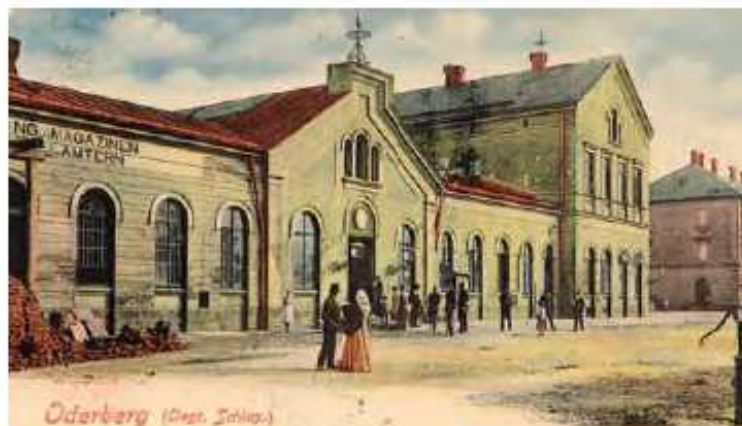
Bohumín, výpravní budova po prvním rozšíření v letech 1868–1870, pohled z ulice. Sbírka Mojmír Letánský, pohlednice, 1904 prošlo poštou.
