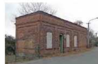
Lipník nad Bečvou, bývalá acetylenovna stav v roce 2011.
