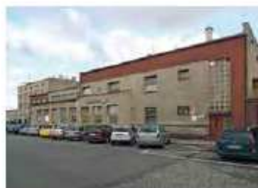
Hranice na Moravě, výpravní budova, stav v roce 2012.
