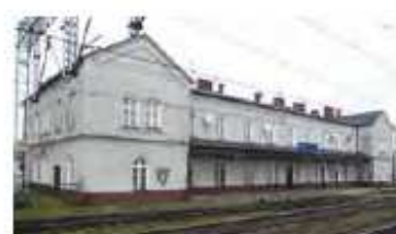
Chybiě, Polsko, výpravní budova, stav v roce 2009.
